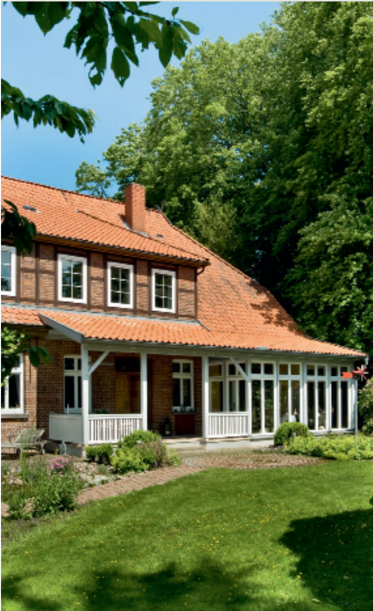
Das alte Dach findet seine Fortsetzung in dem angeschleppten Dach des Anbaus.
